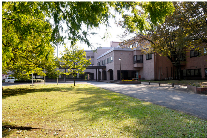
正門付近からみた本館
