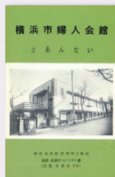
横浜市婦人会館 ごあんない ※1927年に横浜市連合婦人会館として建てられた施設
